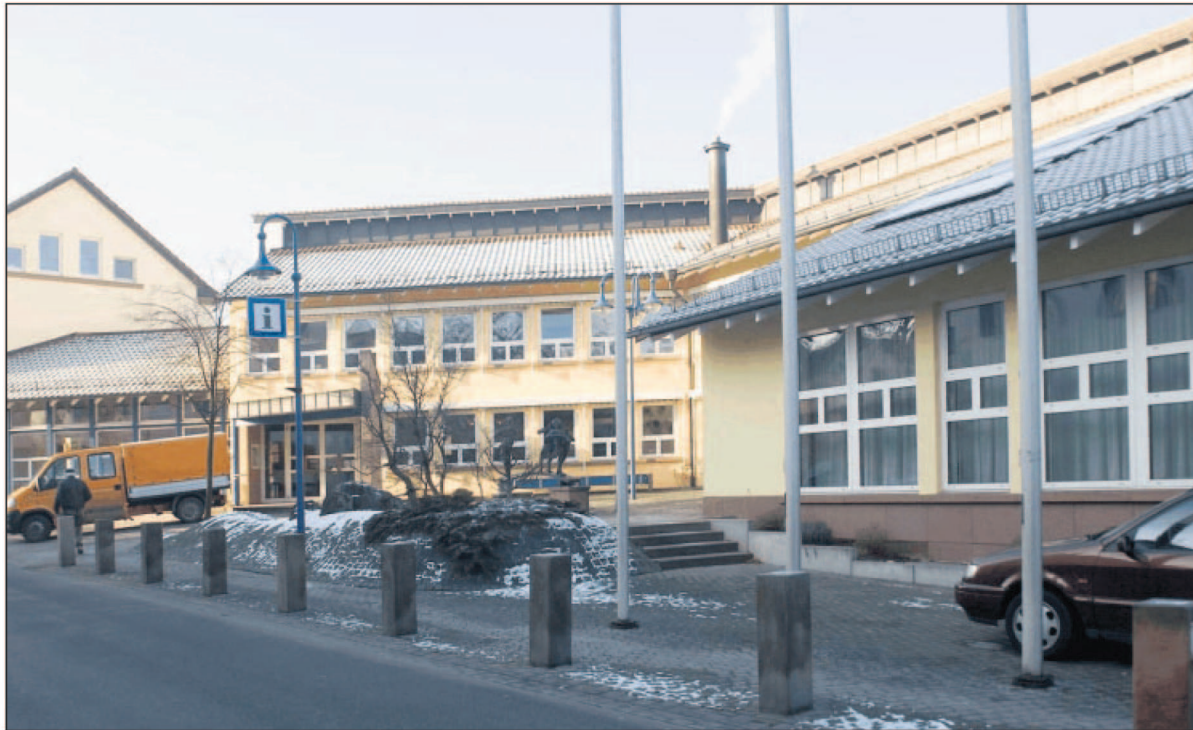
1988/89 wurde das Verwaltungsgebäude in Weilerbach gebaut. Eine vom Verbandsgemeinderat akzeptierte Planung für den Umbau sieht vor, den Ratssaal (rechts) abzureißen und für das Bürgerbüro einen neuen Gebäudeteil nach Grundsätzen der Passivhausbauweise zu errichten.
